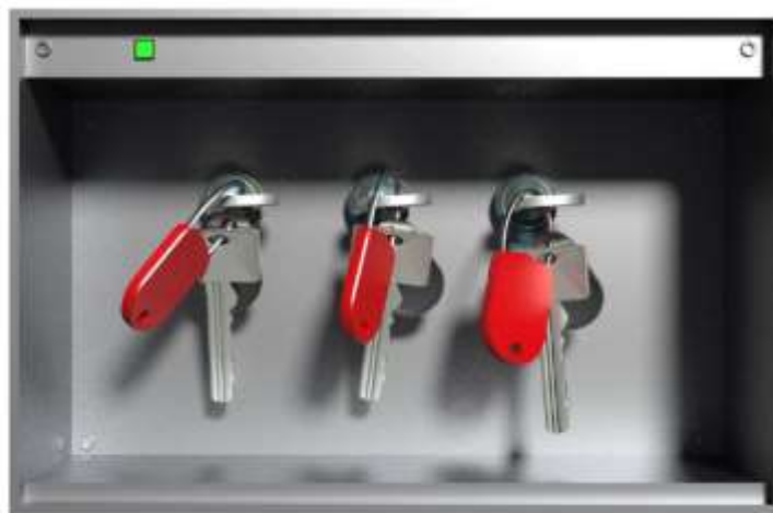
Beispielhafte Schlüssel hinterlegung im FSD: Drei identische Schlüsselsätze, bestehend aus jeweils zwei mechanischen Schlüsseln und einem Transponder (schwarz)
