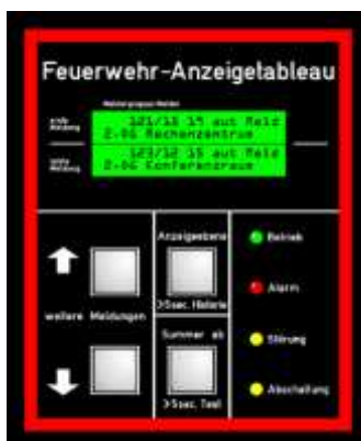
Beispiel eines Feuerwehr-Anzeigetableau
